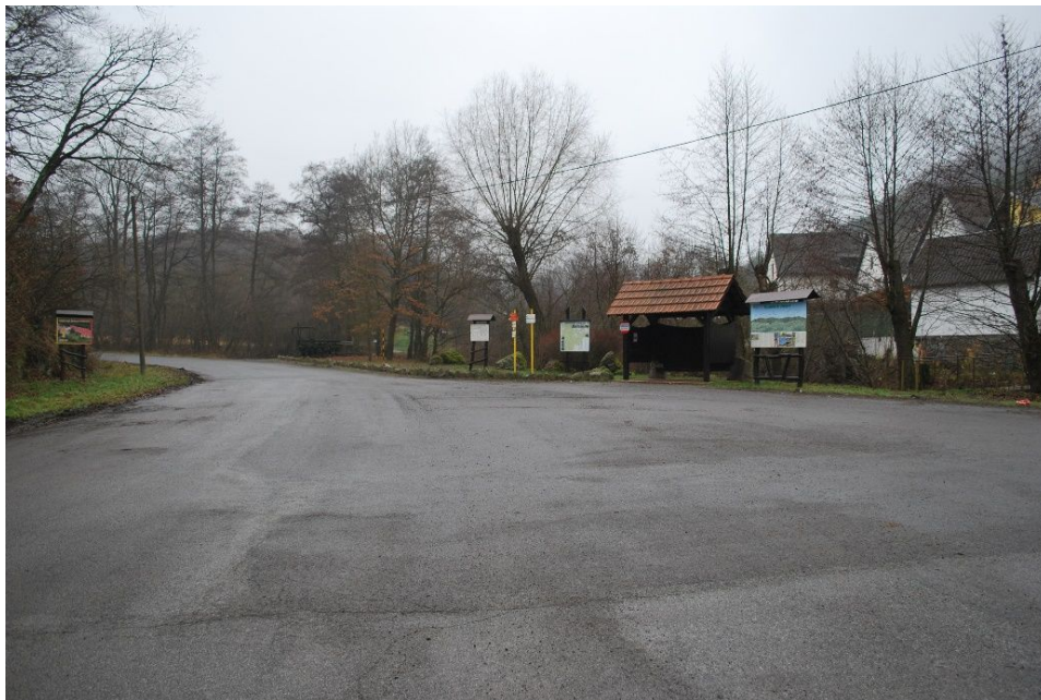
Obr. 7 Asfaltová odstavňá plocha, s autobusovou zastávkou, informačnými tabúľami a turistickými smerovníkmi
